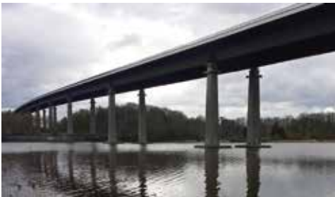
Die Rader Hochbrücke muss bis 2026 ersetzt werden
